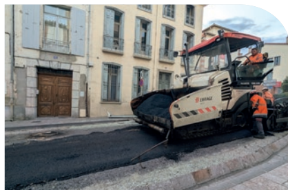
La réfection de la rue Saint-Ferréol a démarré
